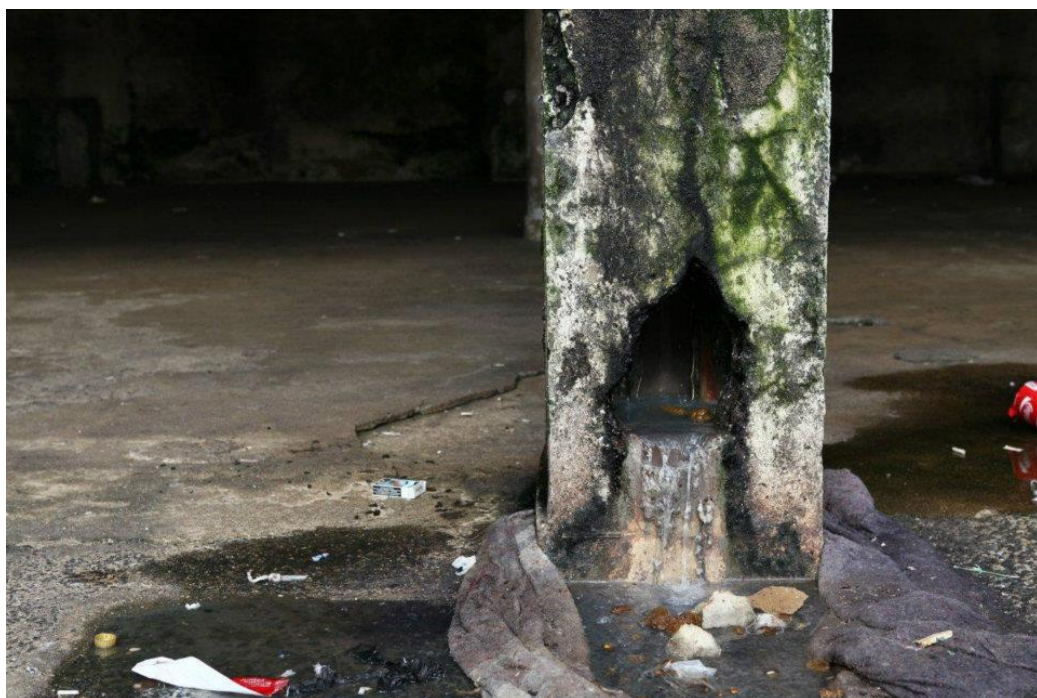
Esgoto desembocando no pátio, sem qualquer tubulação.
